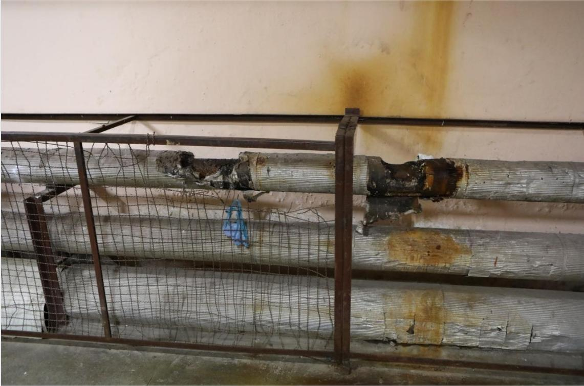
Tubulações estão corroídas e colocam em risco o funcionamento da unidade.
