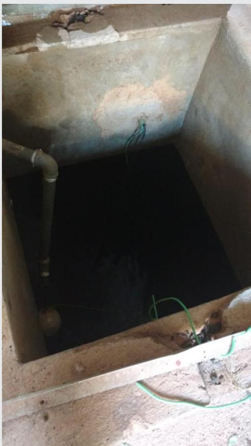
Outro problema: com a falta de contrato de manutenção, que se arrasta a anos e é urgente, é uma rachadura dentro da caixa d'água do HAB. Com isso, a água se infiltra pela parede da caixa d'água e destrói as bases de sustentação.
