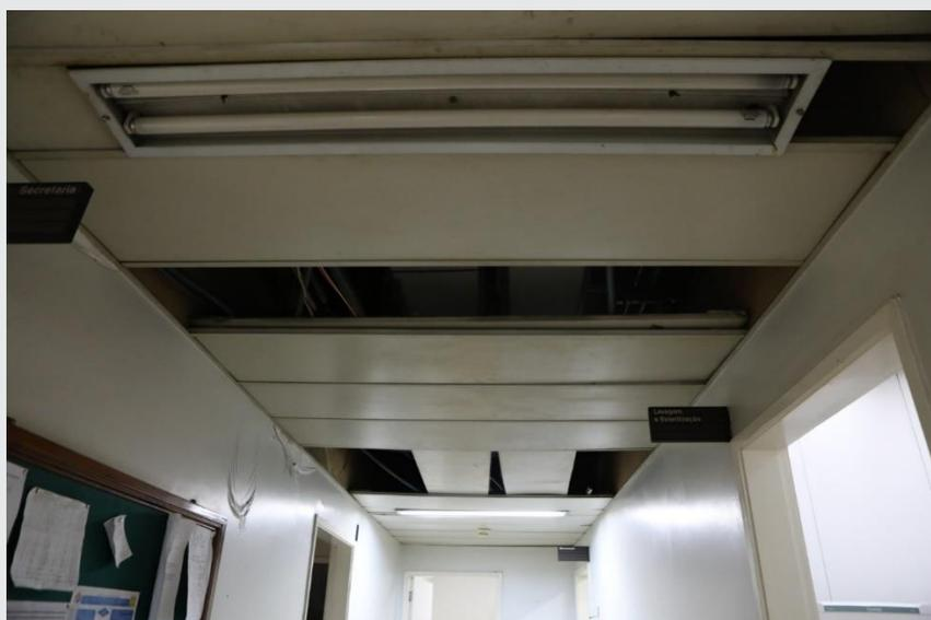
Por toda a unidade, falta forro no teto, o que deixa o cabeamento exposto, bem como as instalações hidráulicas.
