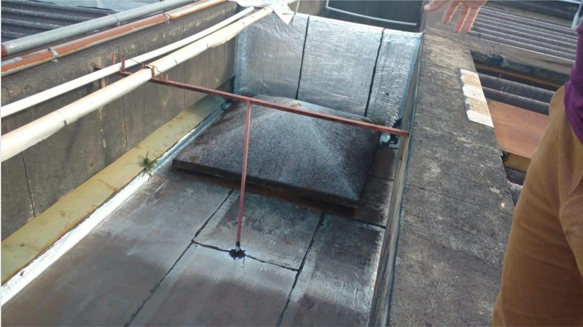
Devido a estrutura antiga dos telhados, quando chove eles viram verdadeiras piscinas a céu aberto. Sem a manutenção necessária, além de causar infiltrações, podem ser foco do mosquito da dengue.
