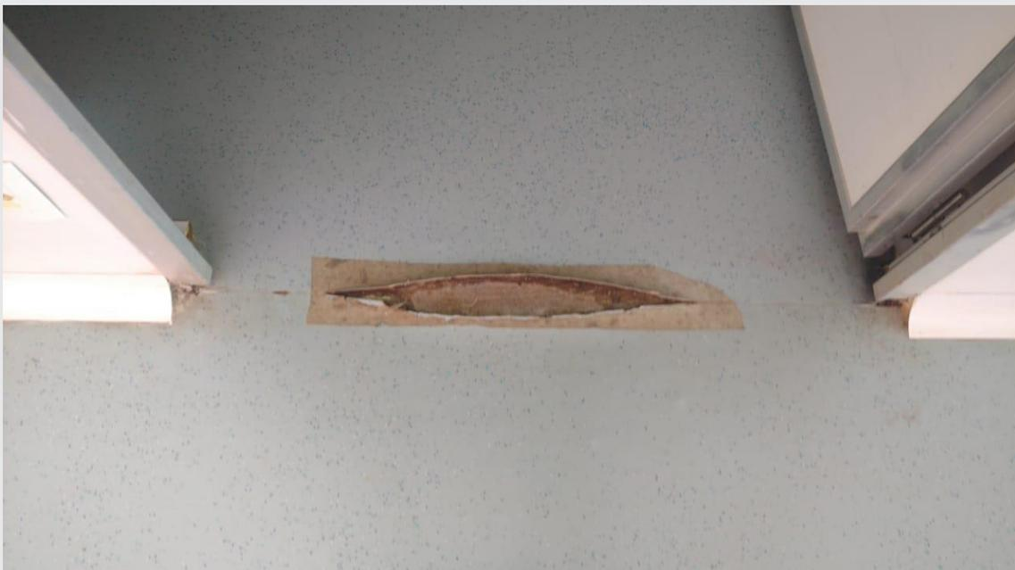
Grande parte do piso da UPA de Sobradinho está descascando ou remendado. Isso ocorre porque não há contrato de manutenção predial na unidade.
