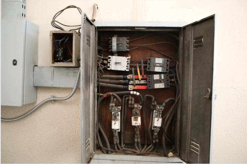
Quadro de energia dos anos 90. A subestação elétrica não suporta a demanda da unidade e impede a instalação de serviços como mamografia e tomografia.
