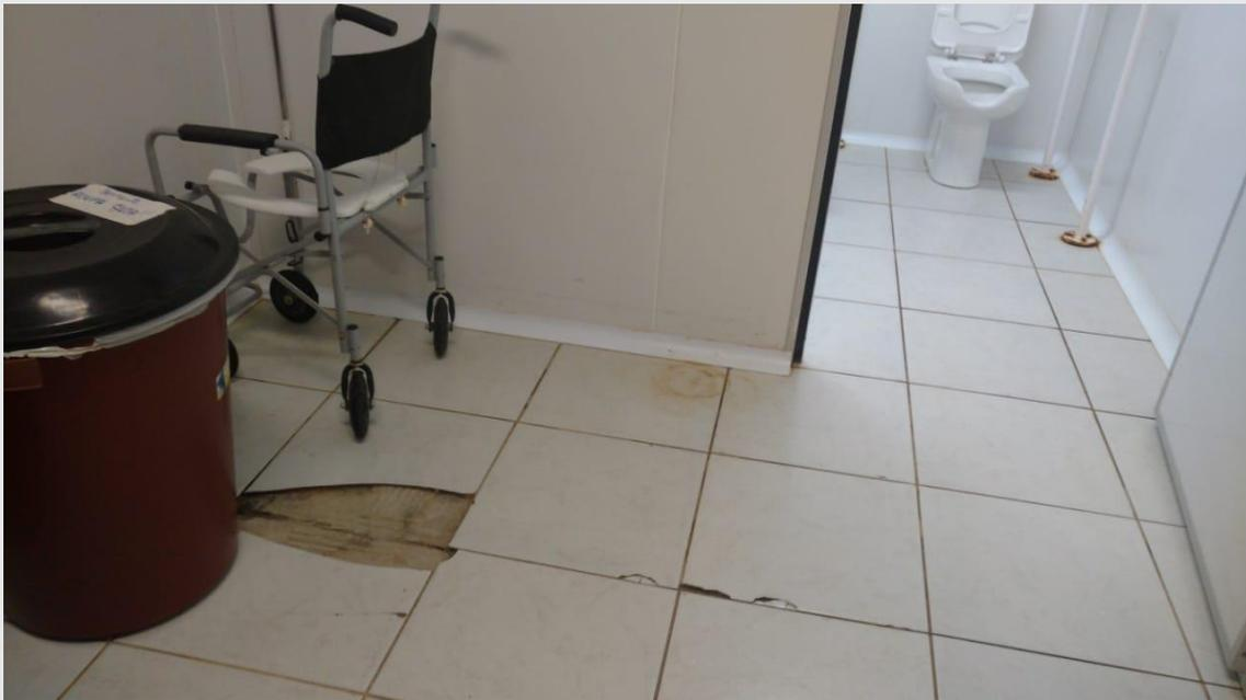
Banheiro da sala vermelha da UPA de Sobradinho está com piso quebrado e tem alagamento devido a um problema de escoamento da água.
