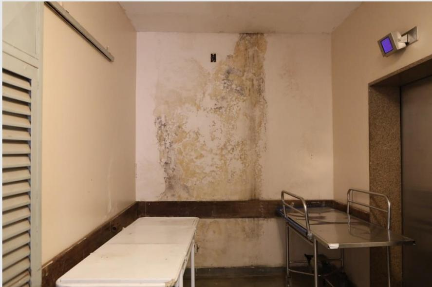
Vazamento de esgoto na Anatomia Patológica e em demais setores, pois o Hospital está sem contrato de manutenção.
