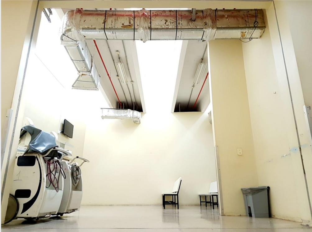
O ar condicionado com sistema central funciona parcialmente. Está sem manutenção.
