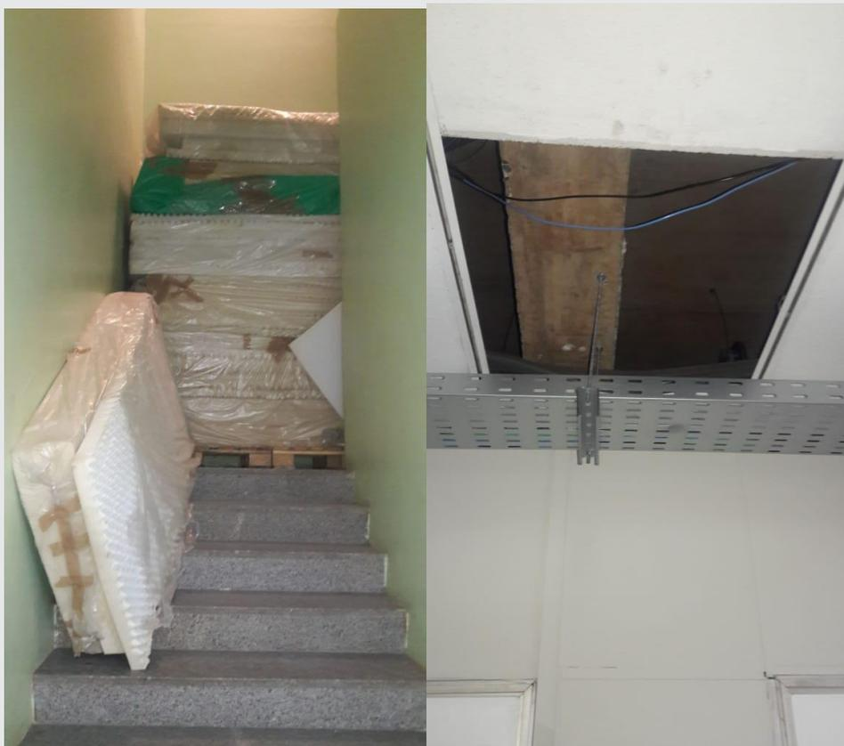
Depósito improvisado na escada de acesso ao telhado e falta de placas no teto da área externa do ambulatório do HRGu.
