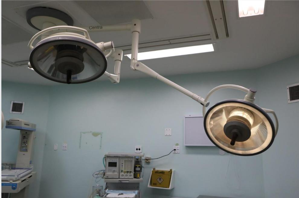
A capacidade assistencial do hospital é prejudicada pela falta de manutenção de equipamentos. A exemplo, o foco cirúrgico com a lâmpada quebrada e com uma estrutura que se move - enquanto deveria ser fixa. A instabilidade do aparelho apresenta risco ao paciente.
