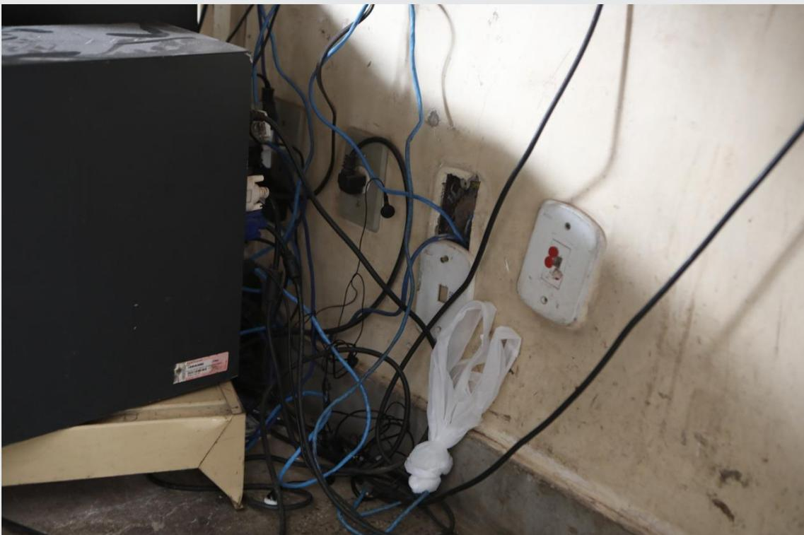
Falta de ventilação e fiação exposta nos guichês de atendimento.
